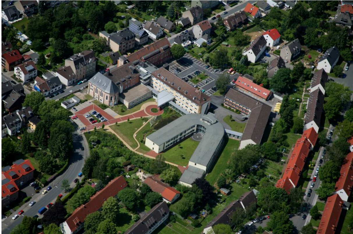
Luftaufnahme des Marien Hospitals in Hombruch
